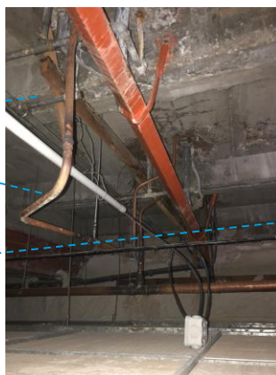
Poutre béton (ht estimée = 15x15cm)
