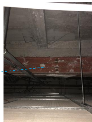
Poutre béton (ht estimée 50x30cm) Renfort de 3 poutres IPN assemblées en sous-face avec tirant métallique (ht estimée 30cm)
